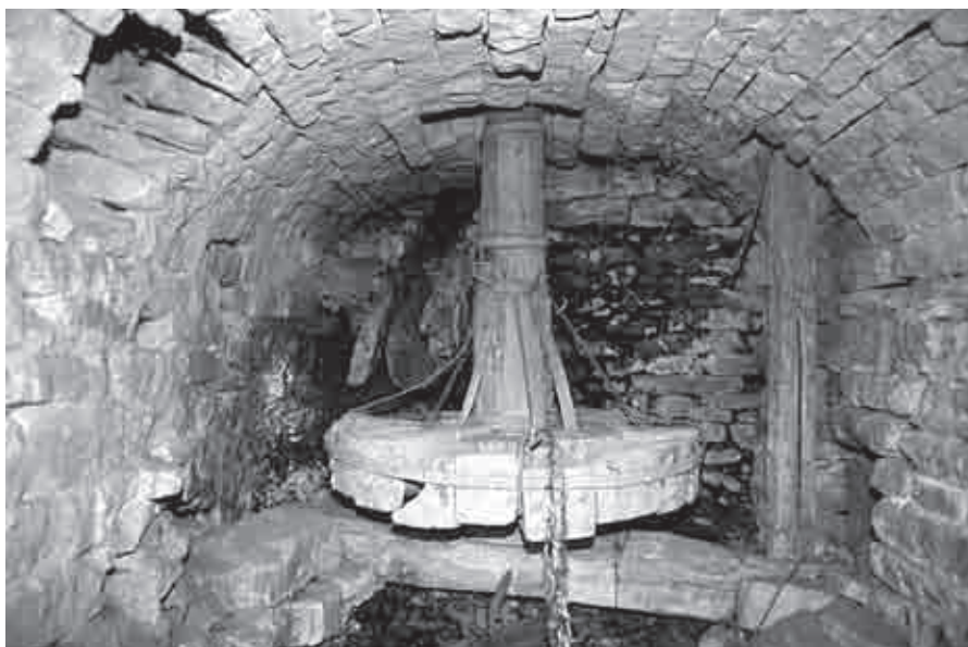
Todo de madera: canal, rodezno, arbol, puente y aliviador. El rodete gira en sentido contrario a las agujas del reloj (Ainielle, 2002)
