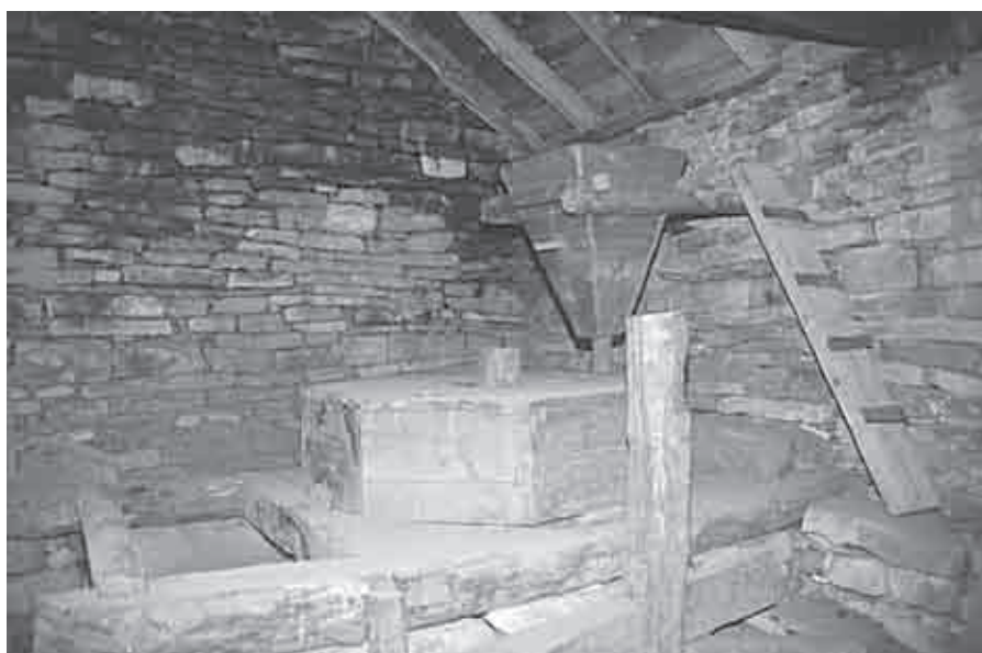
Sala de molienda con una pareja de muelas, un guardapolvo octogonal, un farinal y una tolva sujeta a la pared. Falta la canaleta. La viga en primer plano es el aliviador. (Ainielle, 2002)
