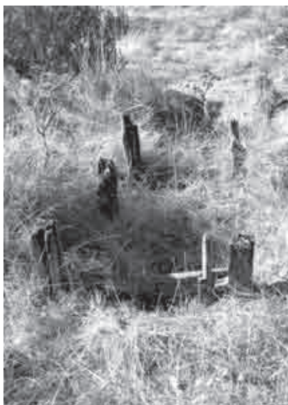
Por medio de un sistema de válvulas de madera, el agua superflua volvía al río por un ramal. (Lacabazonada, 2011)
