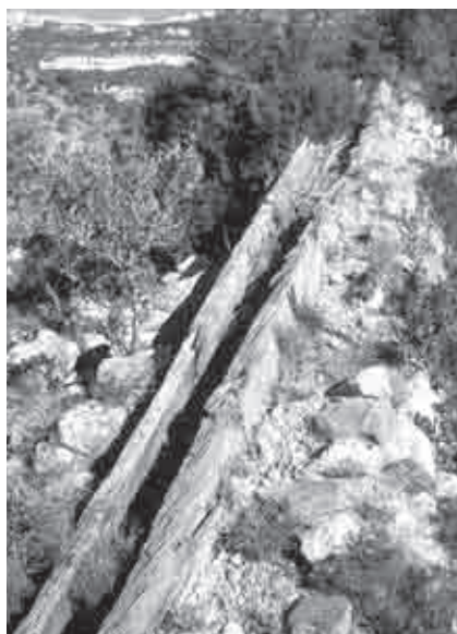
Un tronco ahuecado transporta el agua del canal al molino. La inclinación del terreno facilitó el trabajo. (Lacabazonada, 2011)
