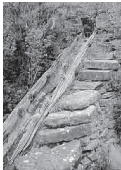
En Ainielle tuvieron que construir una pendiente para soportar el canal. Fijese que aquí se necesitaron reparaciones regulares para mantener la pared. (2002)
