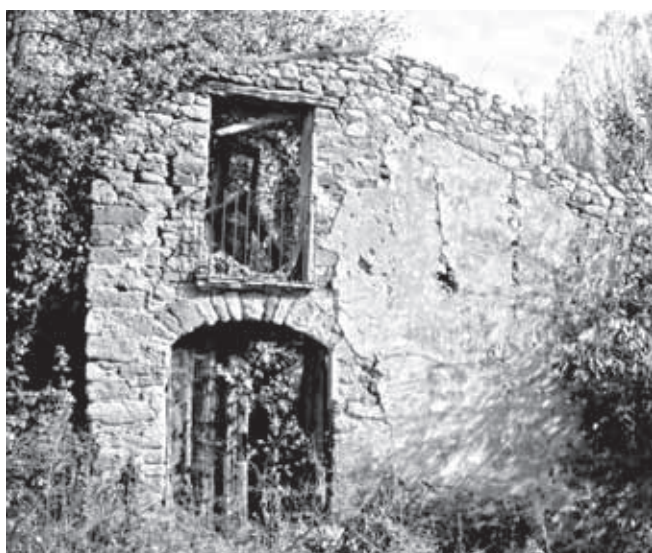
Fachada con, a la derecha de la entrada, un dibujo de muelas. (Arén – 2010)
