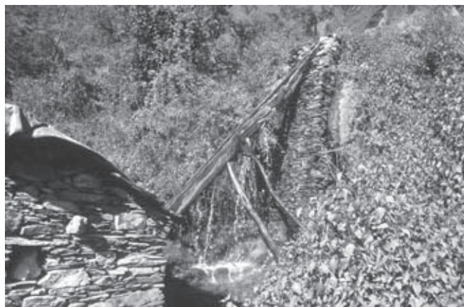
Canal abierto con goteras
