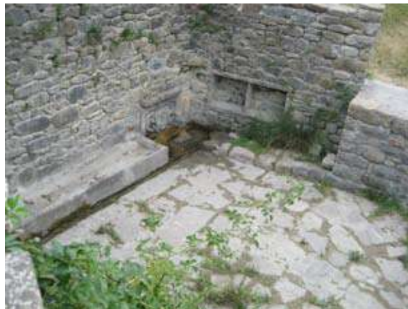
Abrevadero y fuente a la entrada del pueblo. 14.X.2015
