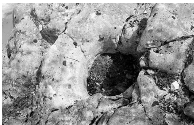
Hueco para las vigas del azud ( 40 \times 40 cm)
