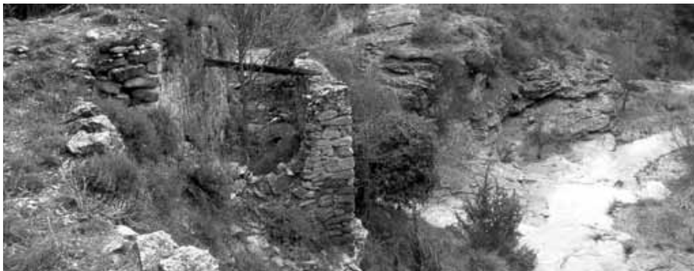
Molino de Porta, ubicado a orillas del Barranco de las Ortogas; a la izquierda, la pared del embalse
