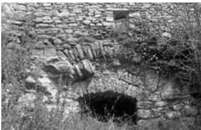
Desagüe con dos arcos suplementarios
