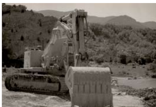
Máquina excavadora en la ataguía, con Jánovas de fondo
