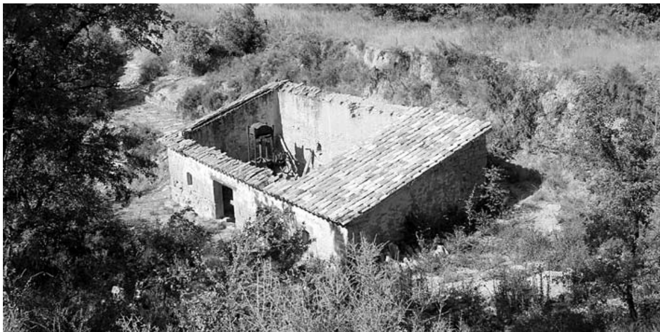
Limpiado de vegetación y escombros; parte del techo renovado
