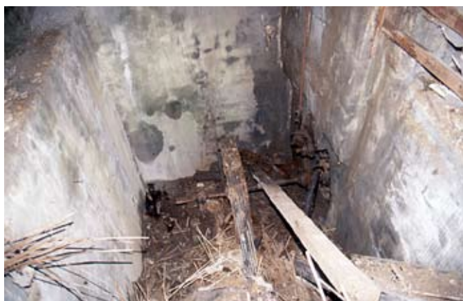
Alternador y turbina 1955
