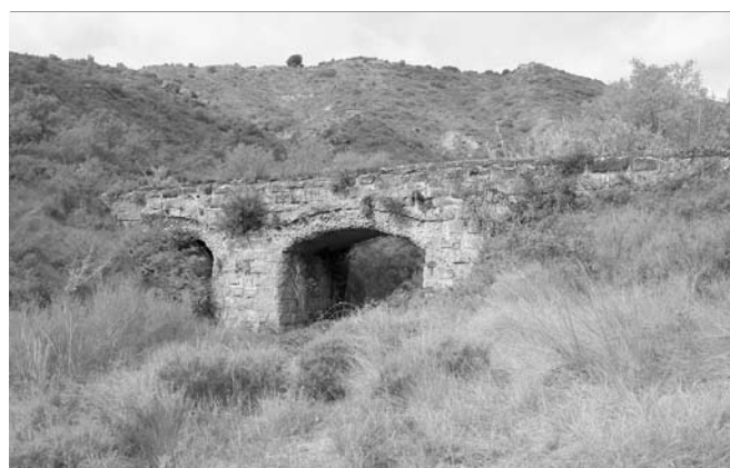
Acueducto sobre el Barranco del Mont
