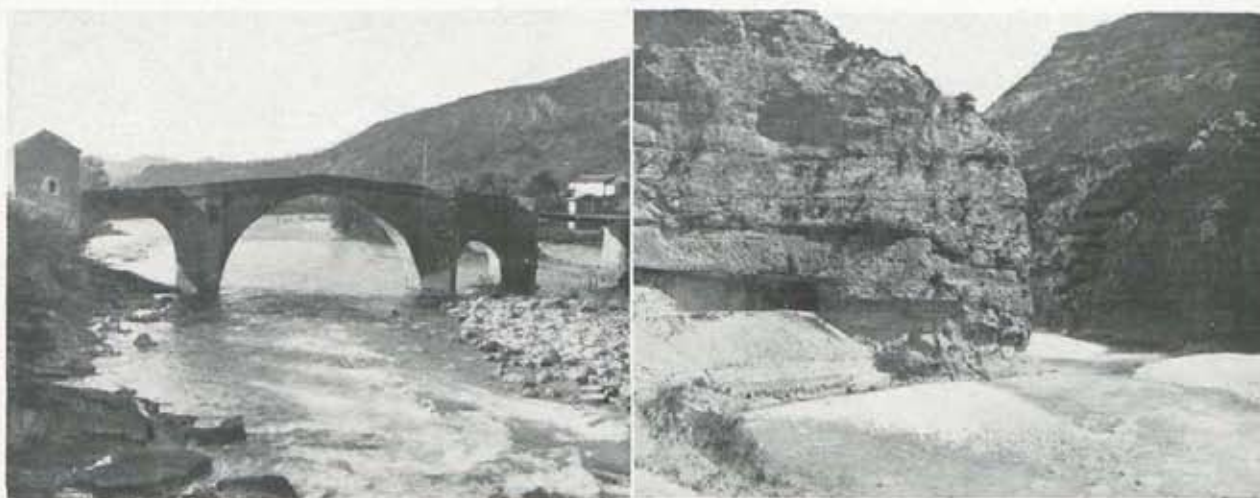
De izquierda a derecha: Boltaña, puente sobre el río Ara. Túnel de Tanavas
