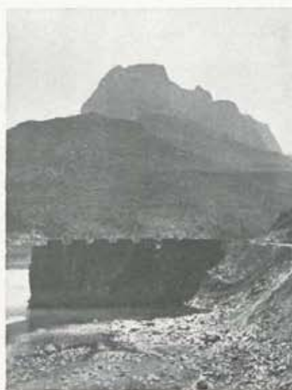
Estribo partido por la corriente del río
