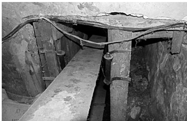
Alternador Siemens movido por una cinta
