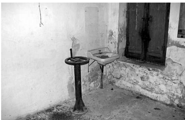
Rueda de control para la turbina MM-Aragonesa
