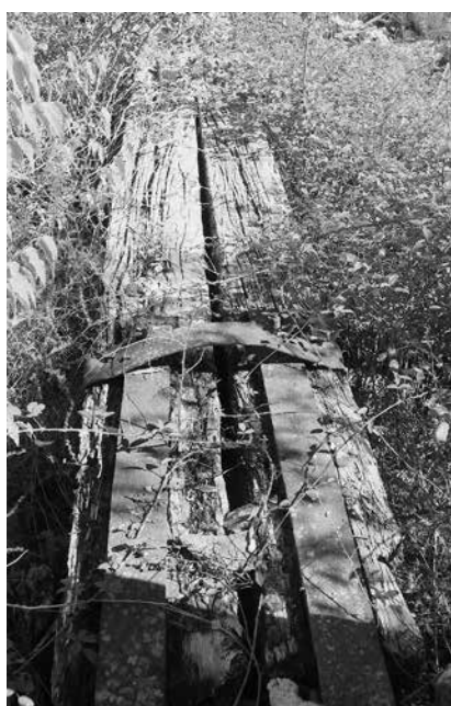
Refuerzo de la viga
