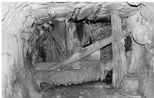
Rodete cubierto de cal
