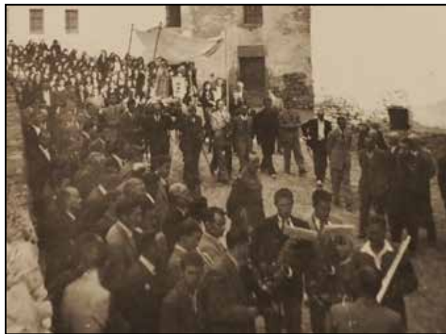
Bajada desde la carretera a la iglesia
