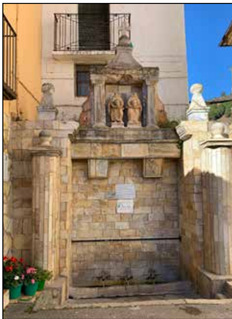
Foto 2. Torrijo de la Cañada. Fuente de los Santos. Vista general
