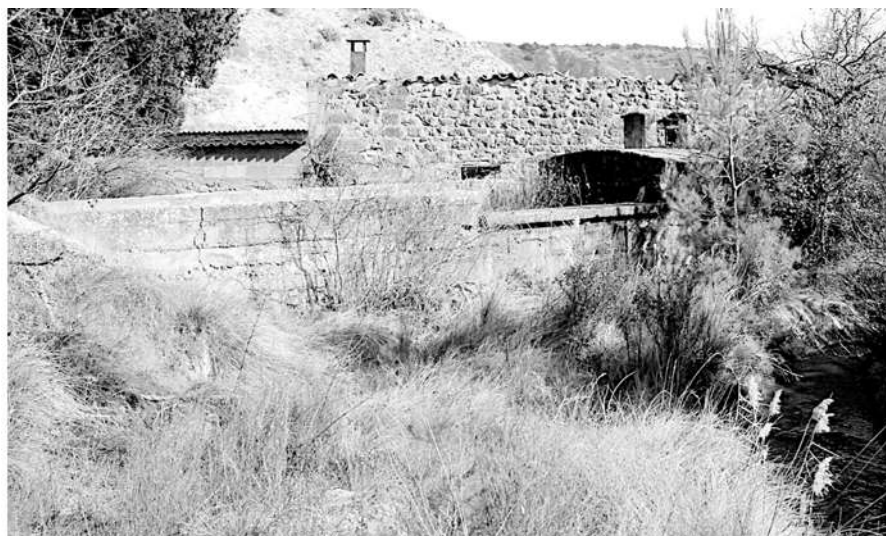
Final del canal con desagüero
