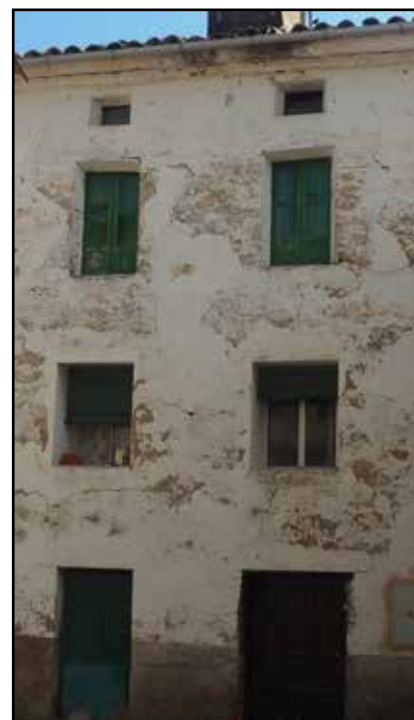
Fachada de la casa escuela de Escanilla
