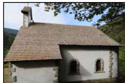
Tejado restaurado con tablillas de haya
