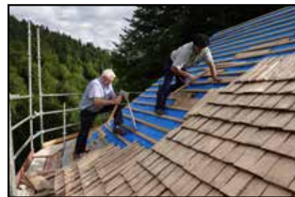
Colocación de las tablillas en el tejado
