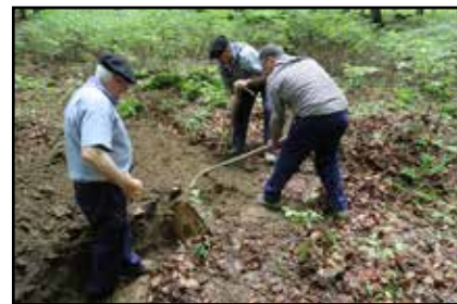
Enterrando un rollo bajo tierra
