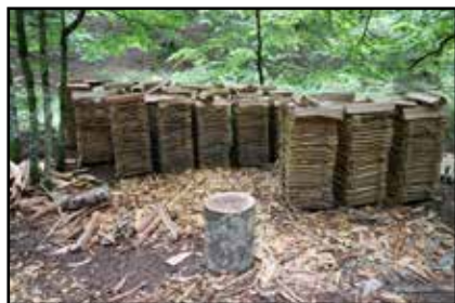
Tablillas apiladas hasta su colocación
