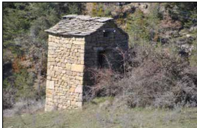
Transformador en Gillué
