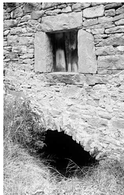
Ventana sobre el cárcavo — 13
