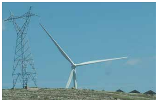
Todo junto. Solar, eólica y torres de conducción
