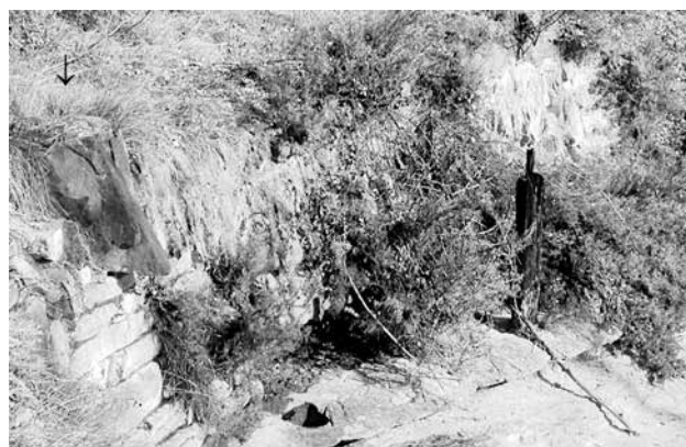
Rastros de una antigua presa de madera
