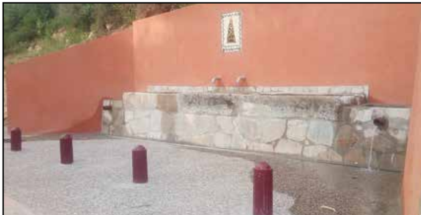
La fuente tras las obras de restauración
