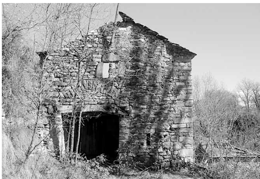
Fachada añadida posteriormente
